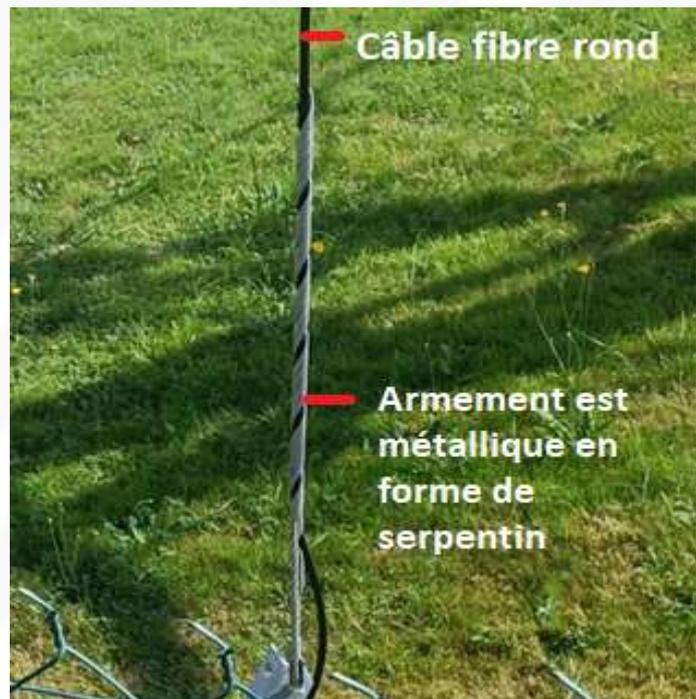
**CABLE du RESEAU CUIVRE => Câble double-corps en forme de 8
